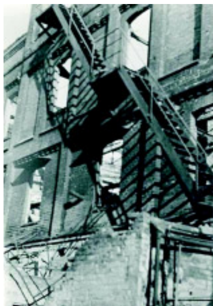
Abb. 11. In der Nacht vom 8. auf den 9. Okt. 1943 wurden die Gebäude in der Dreyerstraße in Hannover zu 90 % zerstört.
