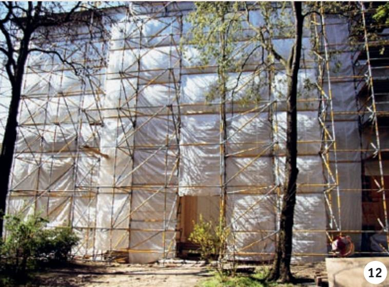
2007–2009: Zur Instandsetzung von Kuppel und Dach muss das komplette Gebäude eingerüstet und mit einem Schutzdach versehen werden.
