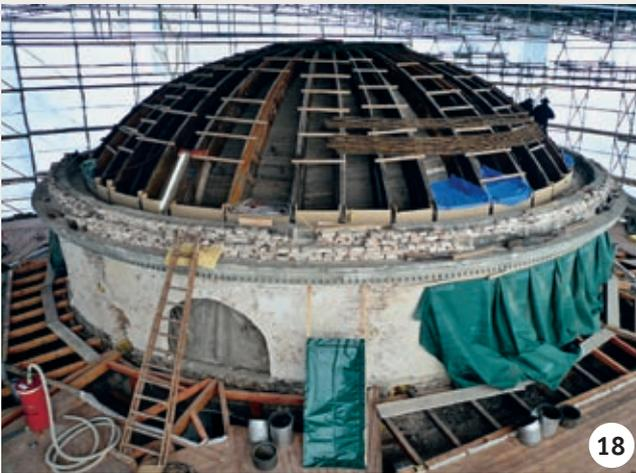
Für die gezielte Schädlingsbekämpfung mittels Warmluft muss die komplette Kuppel eingehüllt werden (hier: Blick auf die Kuppel, die alte Verschalung wurde abgenommen, der umliegende Flachdachbereich wurde bereits neu verbrettert).
