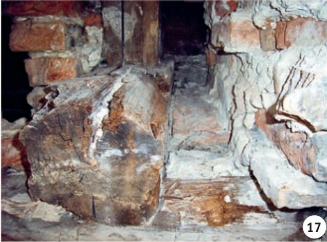
2008/2009: Verzögerung durch unerwartete Schäden: Bei der Freilegung und Untersuchung der Holzkonstruktionen stellt sich heraus, dass insbesondere die Bohlenbinderkonstruktion der Kuppel massiv geschädigt ist: Hausschwamm, Moderfäule und tierische Schädlinge haben das Holz teils nahezu komplett zerstört.
